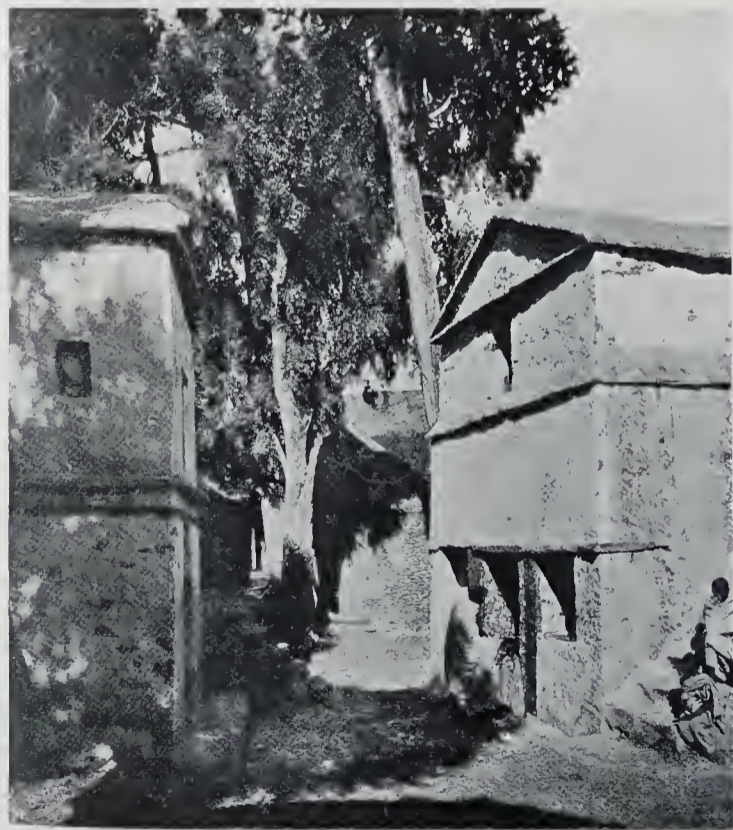
Abb. 231. Links Torhaus, rechts Südfront der kleinen Zionskirche.
